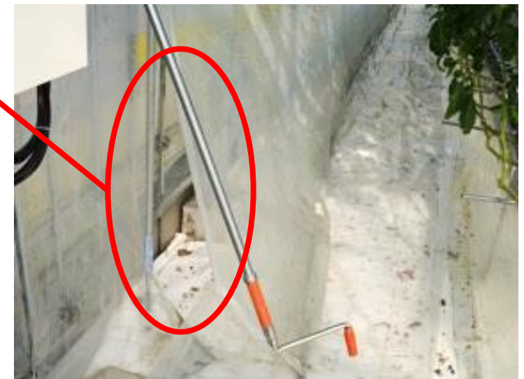
写真8：冷氣による膨らみ
