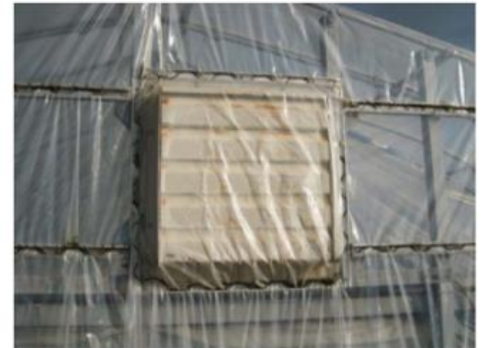
換気扇のシャッターを目張り
