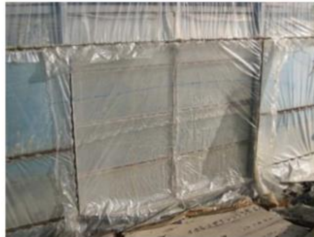
使用しない出入口を目張り
