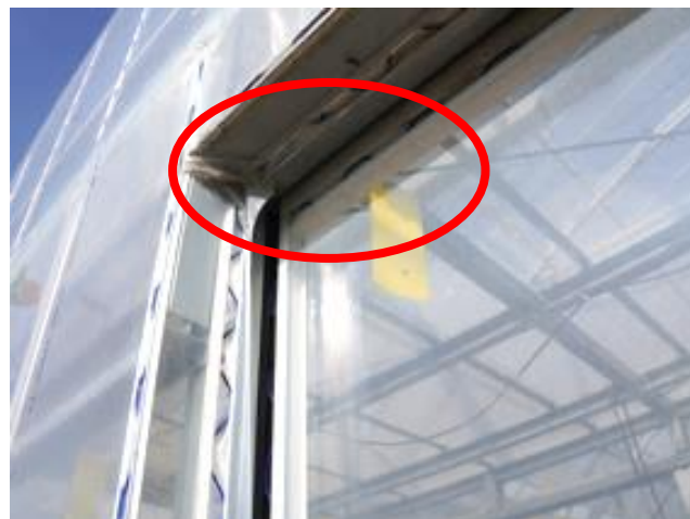
写真6：出入口の隙間直し
