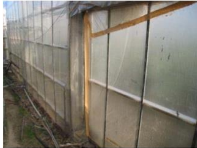
外張被覆の隙間を目張り
