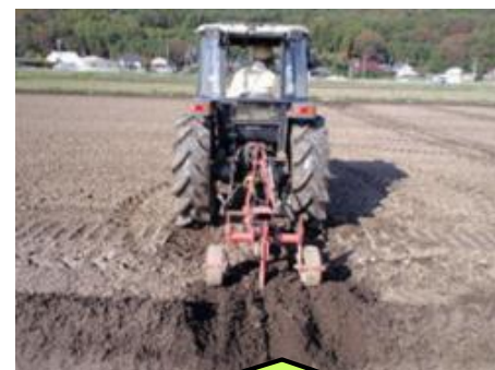
暗きよ、明きよの施工例
